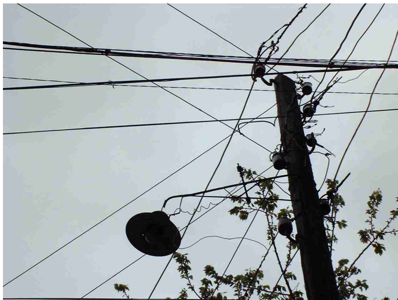
A noter le petit fil tordu qui va à la lampe...
